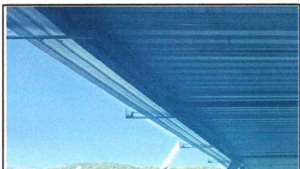
FOTO 9: Sustitución de canal de metal En Aulas
