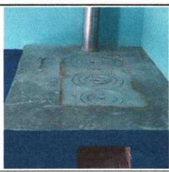
FOTO 12: Sustitución de plancha de metal de 3 hornillas y chimenea, en cocina
