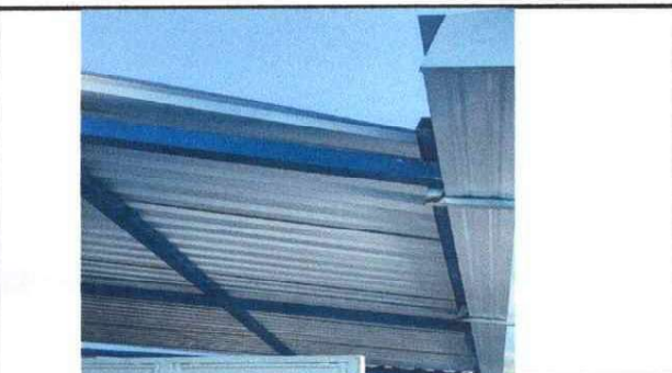
FOTO 3: Sustrucción de canal de metal Y Reparación de bajada de agua pluvial, tubo PVC 3" En baños.
