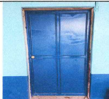
FOTO 8: Mantenimiento a estructura (lijado, cambio de tubo, cepillado, sujeciones, aplicación de pintura) PUERTAS EN AULAS
