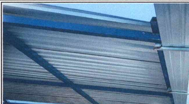
FOTO 2: Sustrucción de estructura de soporte de madera, por metal. En baños.
