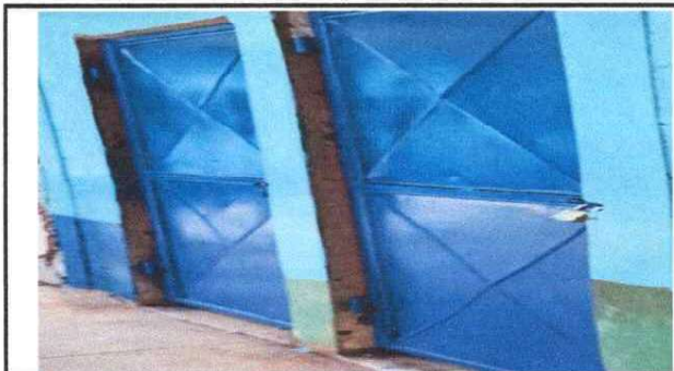
FOTO 4: Mantenimiento a estructura (lijado, cambio de tubo, cepillado, sujeciones, aplicación de pintura) a puertas servicios sanitarios. En baños.
