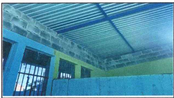
FOTO 11: Reparación de muro perimetral de block. En aulas
